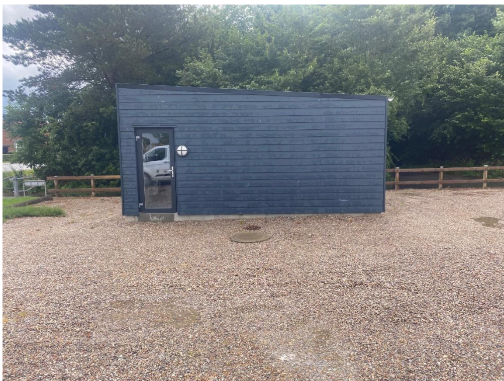
Billede 4 - Pumpehus set fra Vest
